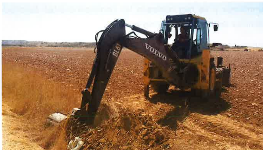
Fotografía 2: Detalle de excavadora empleada en las calicatas mecánicas.
